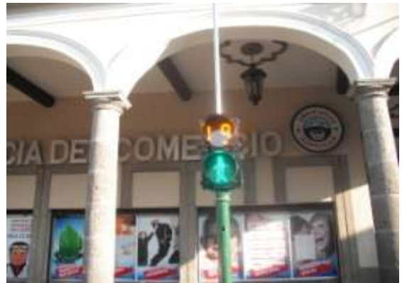
Semáforo peatonal de la Av. Reforma
