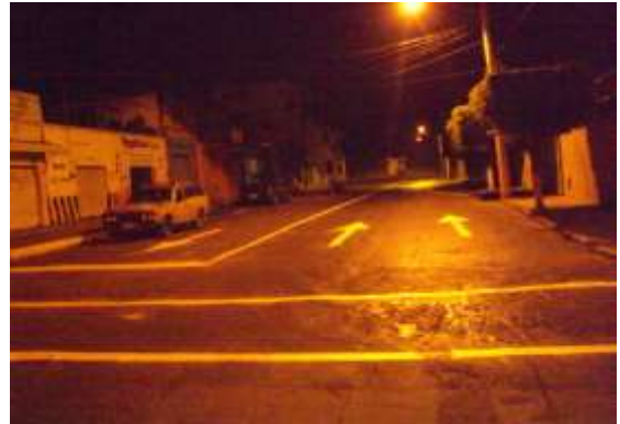
Balizamiento Calle de Ramón Corona
