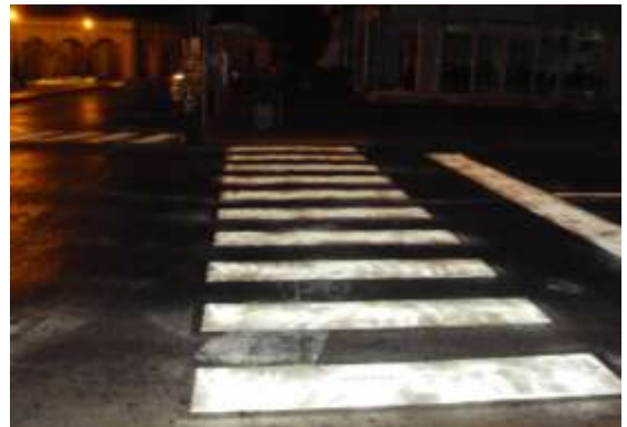
Balizamiento de la calle 1° de Mayo
