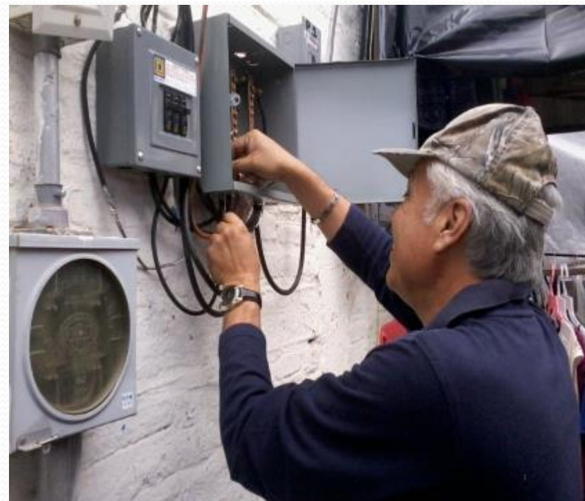
COLOCACION DE LINEAS DE LUZ PARA TIANGUIS NAVIDEÑO
