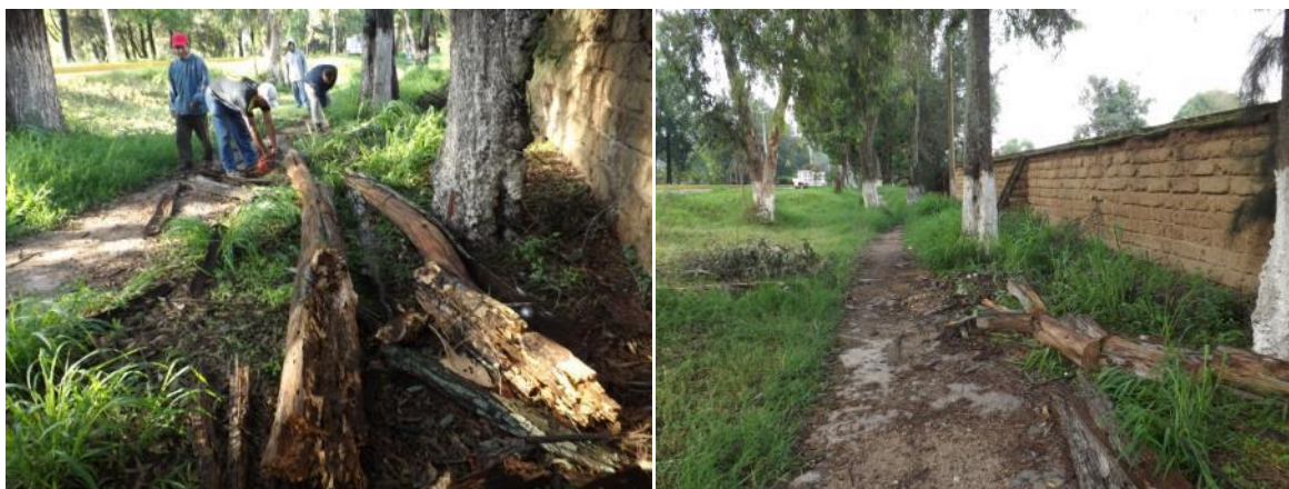
Retiro de árbol Colapsado en el lateral del Ingreso Norte.
