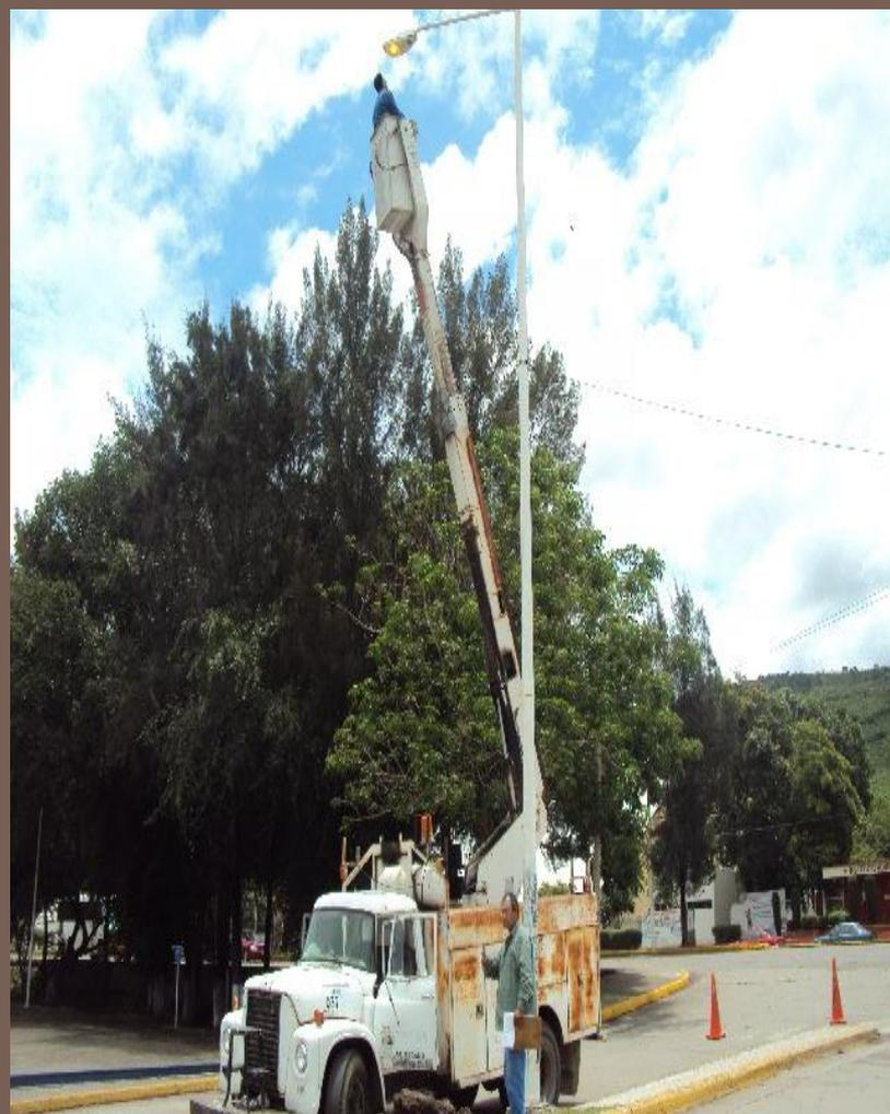
REVISIÓN DE TRANSFORMADOR DE ALUMBRADO QUE ESTA DAÑADO Y SE CONECTO A LÍNEAS DE C.F.E. EN AV. UNIVERSIDAD Y REPARACIÓN DE LÍNEAS
