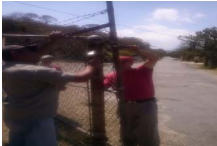
Acomodo de las puertas de la entrada principal
