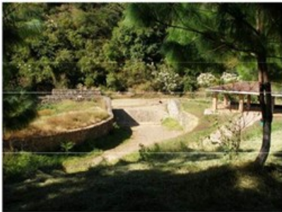
Figura 16. Presa de desvío del arroyo "Los Guayabos", en el parq. Ecol. "Las Peñas"
