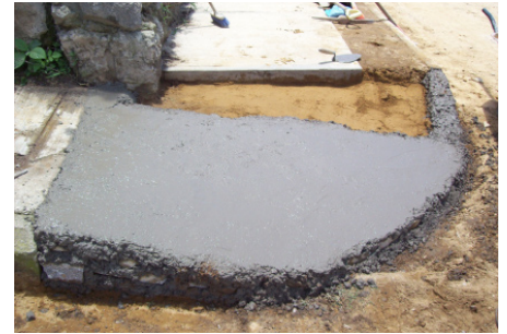
Rampa lado poniente calle Gordoa
