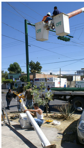
Instalación de Semáforos
