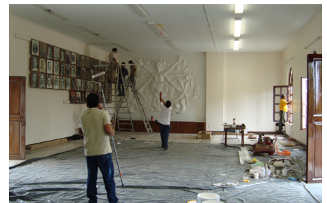
Mantenimiento general de Sala de Ayuntamiento
