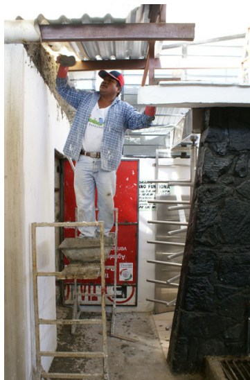
Construcción de baños para discapacitados
