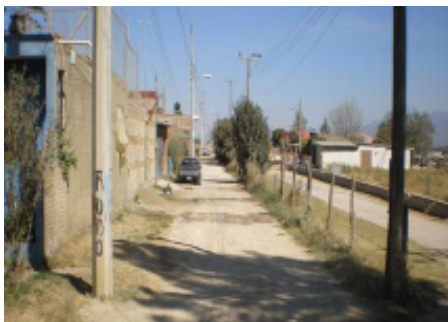
Colocación de Drenaje y Agua Potable Col. El Fresno
