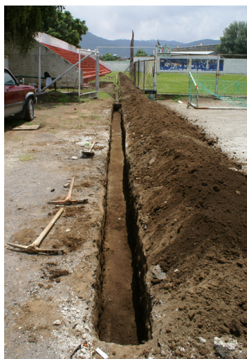
Obras de impermeabilización y nuevo drenaje en Estadio Santa Rosa
