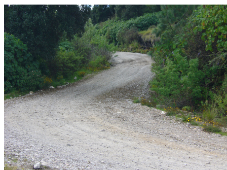
Rehabilitado de brecha km. 16
