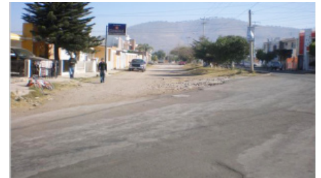
Pavimento asfáltico en Av. Serafín Vázquez
