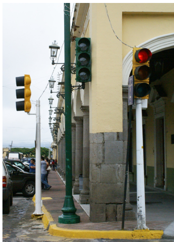
Instalación de Semáforos
