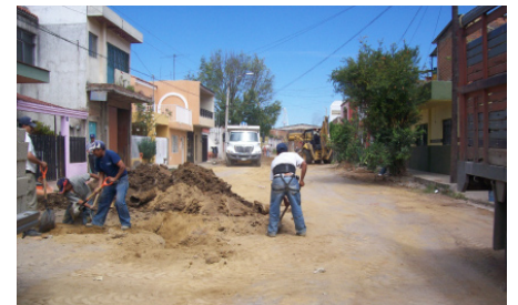
Obras en calle Nayarit
