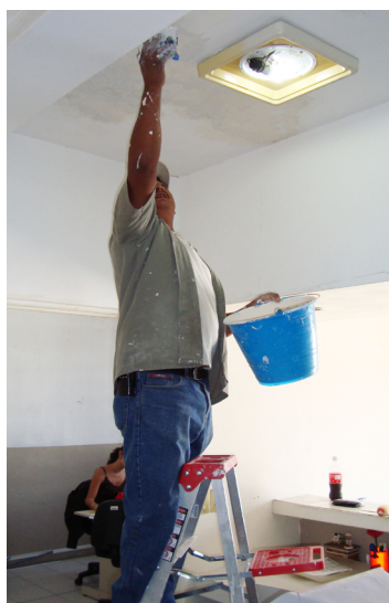
Mantenimiento a oficinas
