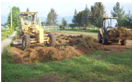
Despalmando y retiro en la colonia La Morita
