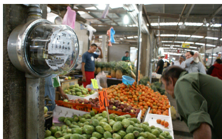
Electrificación en el Tianguis Municipal
