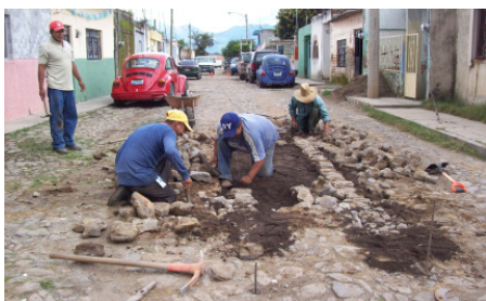
Empedrado en calle Privada Guerrero
