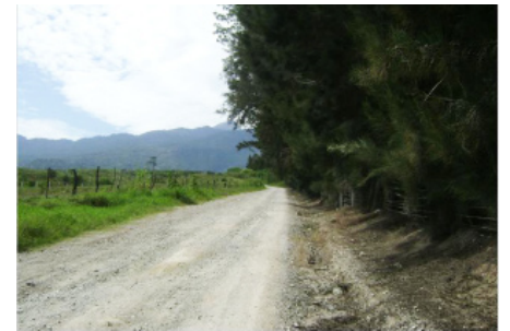
FISE Rehabilitación brecha al Nevado
